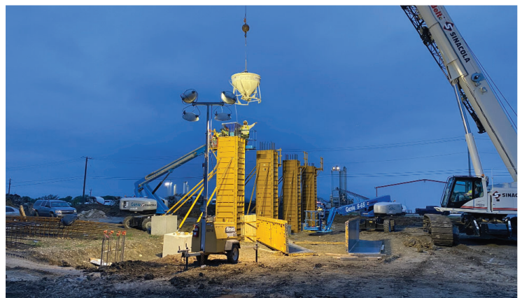
Pouring concrete columns
