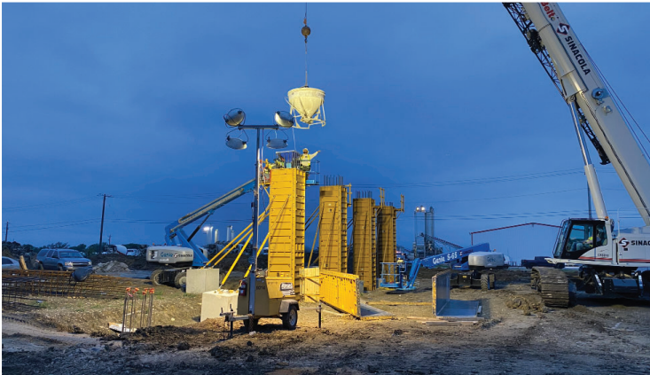
Pouring concrete columns
